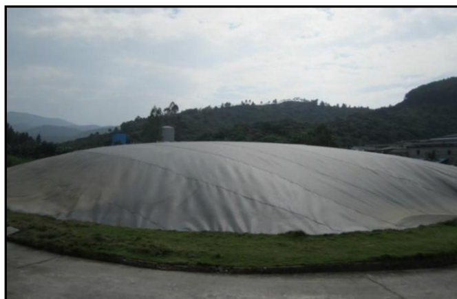
图 2-9 建成后的黑膜沼气池示意图
