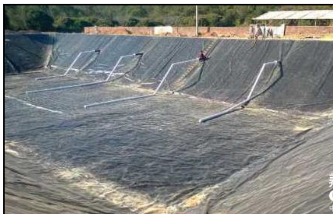
图 2-8 黑膜沼气池内部示意图
